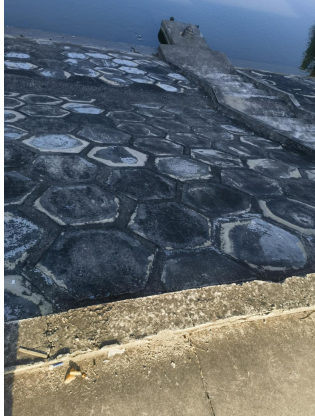
迎水坡（已铺设 C20 砼六角块护坡）
