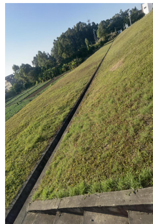
大坝背水坡设置的排水渠
