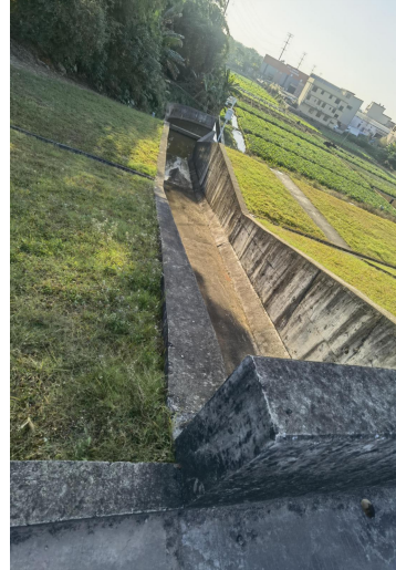
大坝左岸新建溢洪道背水坡现状照片，出水口处新建 C20 素砼挡墙以及 M10 浆砌石护底
