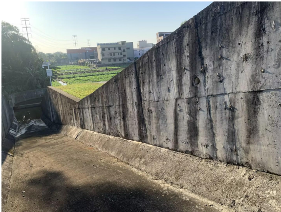
大坝左岸新建溢洪道背水坡现状照片，出水口处新建 C20 素砼挡墙以及 M10 浆砌石护底
