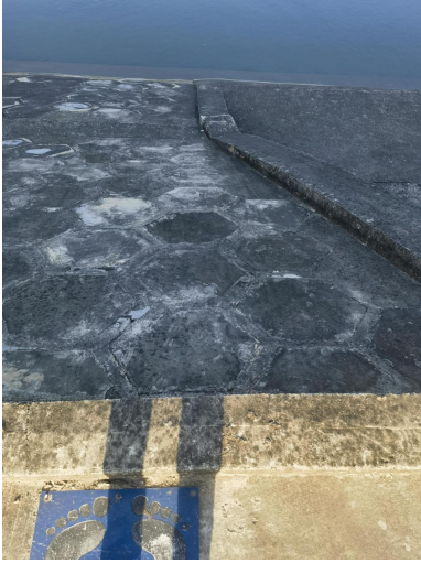
大坝左岸新建溢洪道迎水坡（已铺设 C20 砼六角块护坡）
