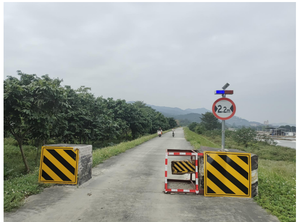
西岸南堤凰岗大道至凰岗隧段路面终点
