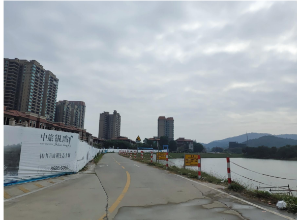
西岸南堤凰岗大道至凰岗隧段路面起点
