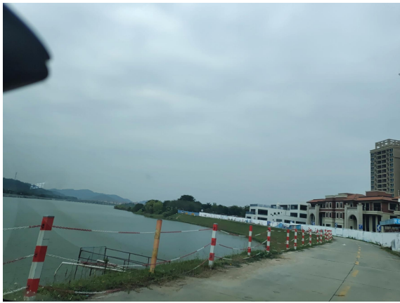
西岸南堤凰岗大道至凰岗隧段路面中段
