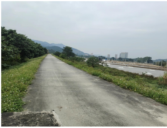
南堤起点连接段路面终点
