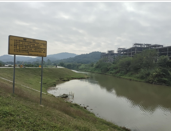
西岸南堤凰岗大道至凰岗隧段路面中段草皮护坡
