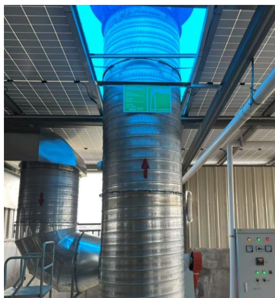
图 3-4o 废气排气筒
