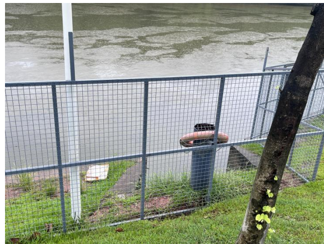
电排站出水涵洞
