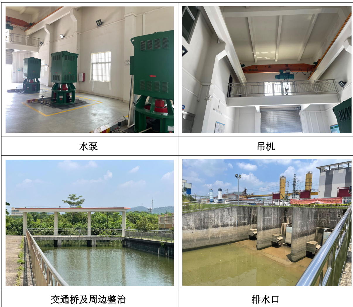
图 3-5 项目现场图片
