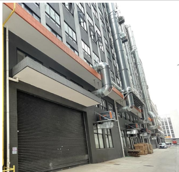
图 3-4n 废气排气筒
