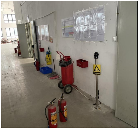
图 3-4f 化学品仓及危废仓（二楼）
