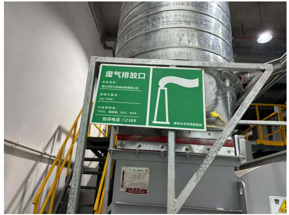
喷漆废气废气排放口标识牌
