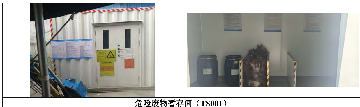
图 5-3 项目危险废物暂存间
