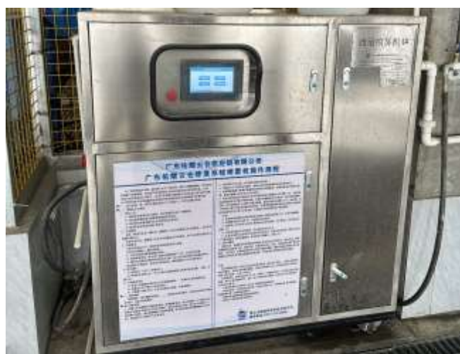
图 3-10k 家禽交易区除臭系统喷雾机
