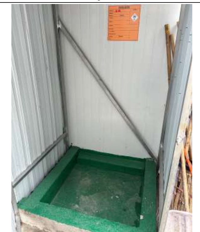
图 3-10r 危险废物暂存间
