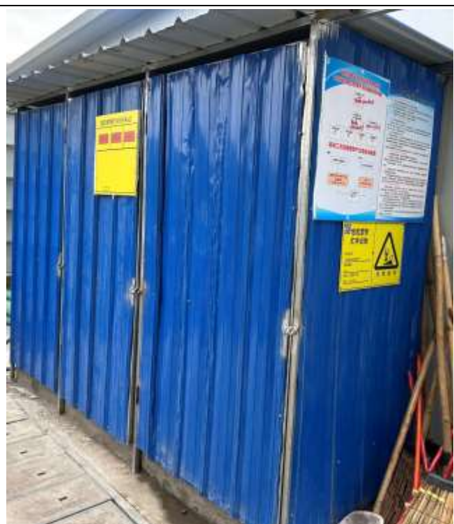
图 3-10q 危险废物暂存间
