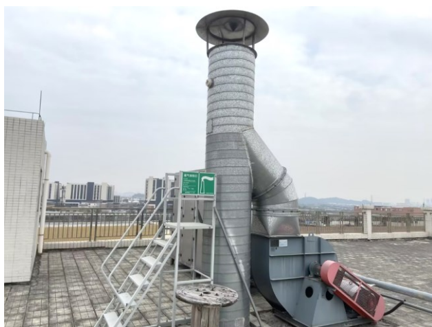
图 3-4n 废气排气筒
