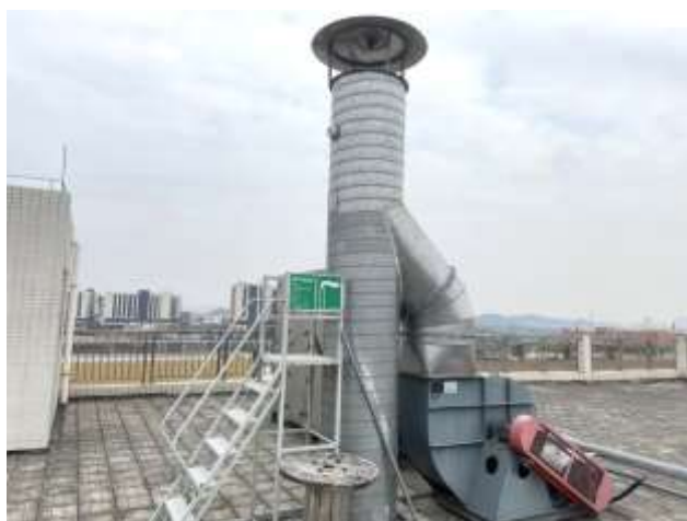
图 3-4n 废气排气筒
