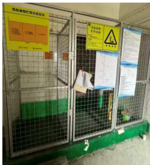
图 3-4o 危险废物暂存间
