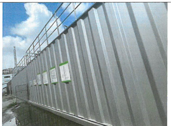
图 3-4h 废水处理设施
