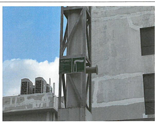
图 3-4l 废气排放口标志牌
