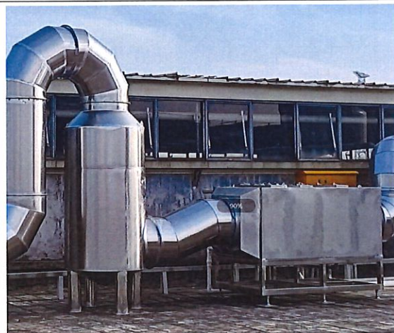
图 5-10 冷凝装置（冷凝）
